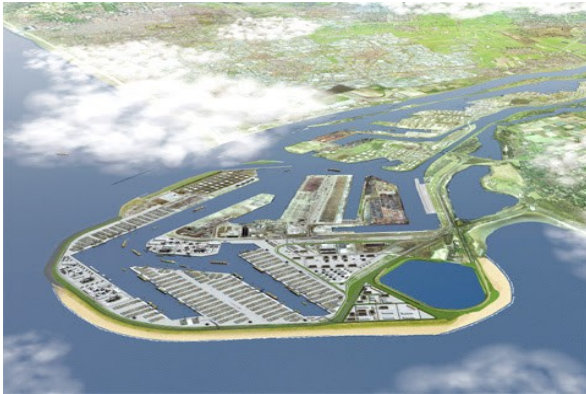
INSTALAÇÃO PORTUÁRIA COM TERMINAIS DIVERSIFICADOS (MAASVLAKTE)
